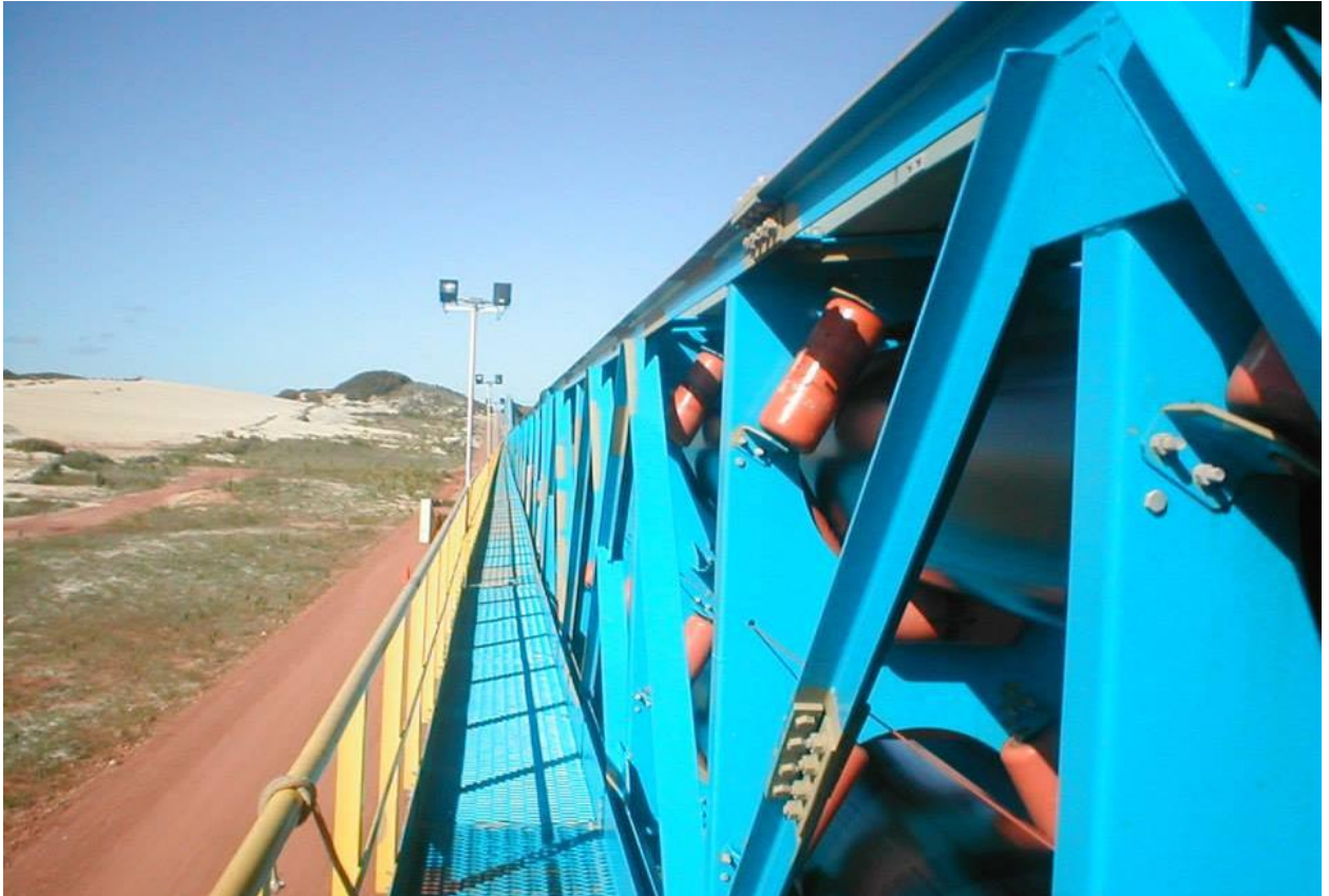
A correia transportadora tubular TC2 em operação
