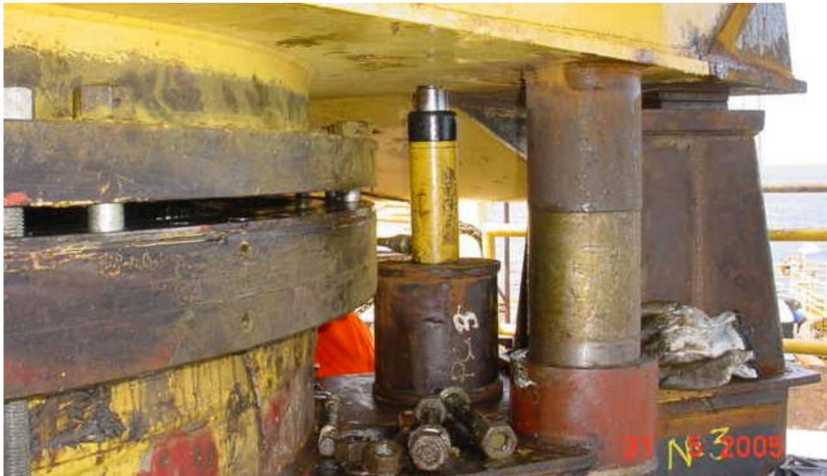
Substituição da pista de giro do guindaste da PAT-3 em andamento, conforme projetado. Fonte: Arquivo pessoal.
