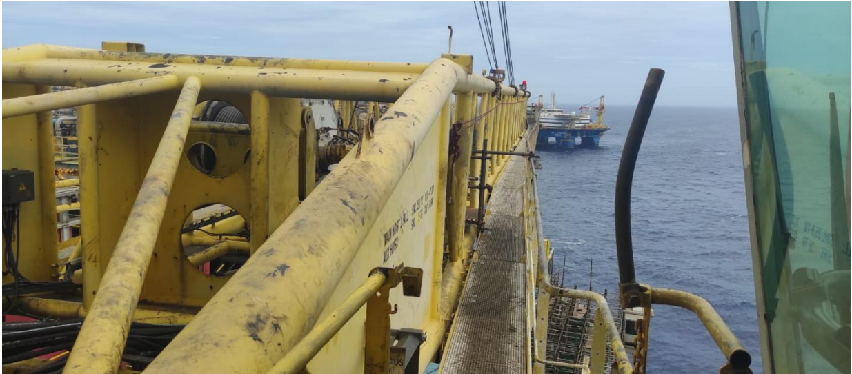
Lança do guindaste Liebherr da plataforma P-51, antes da instalação da sua linha de vida
