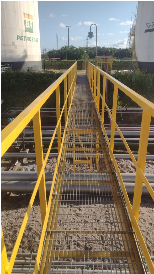
Passarela metálica sobre dutovia, construída e instalada pela JLDT Manutenção sobre projeto AN7.
