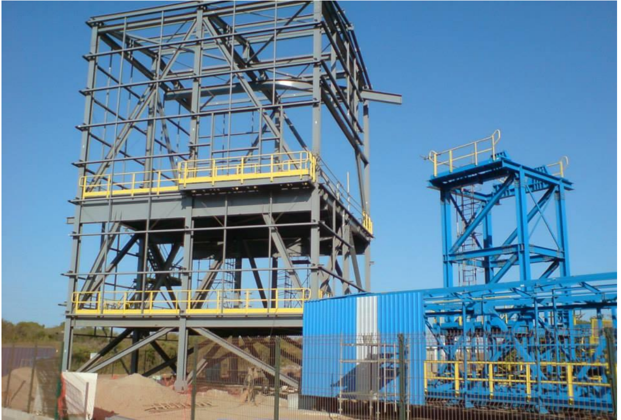
Montagem da torre de transferência TT2, entre os transportadores TC2 e TC3
