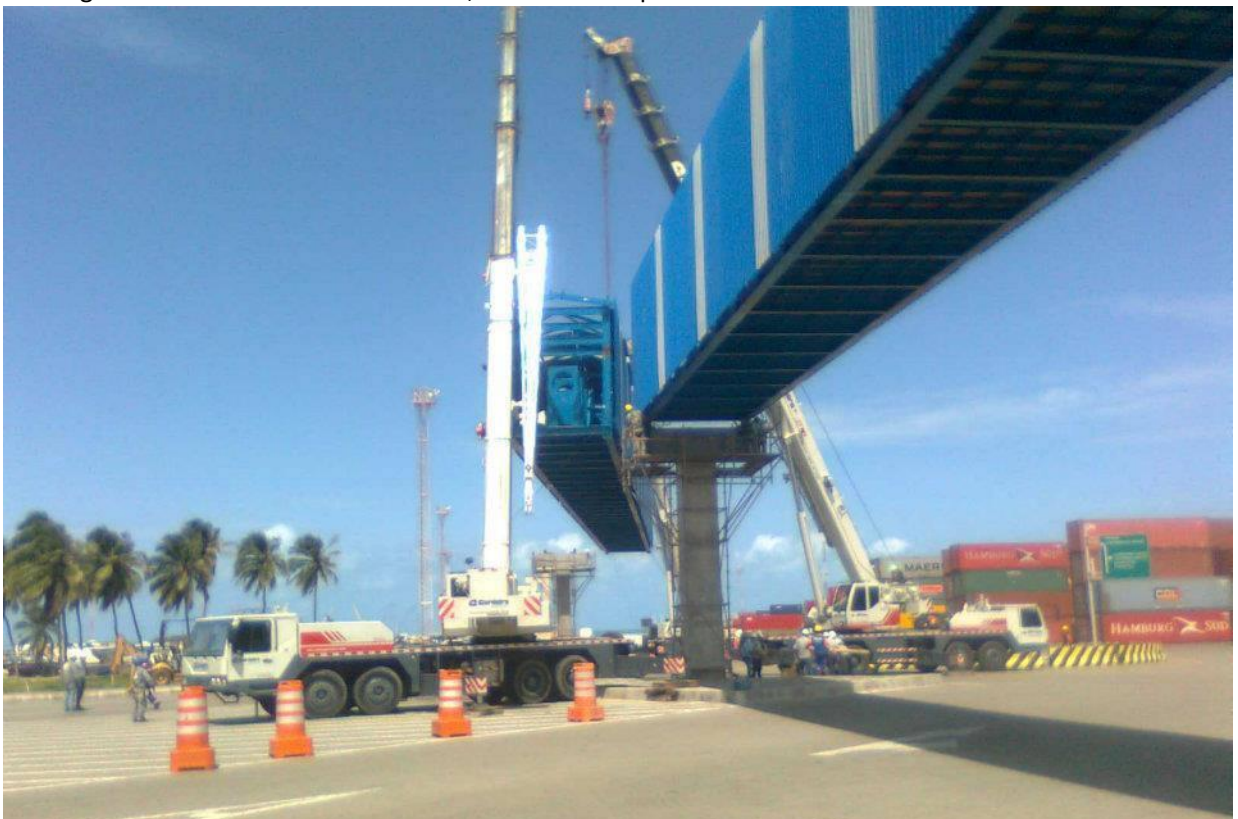
Montagem de módulos da correia transportadora de carvão mineral TC2 em Pecém
