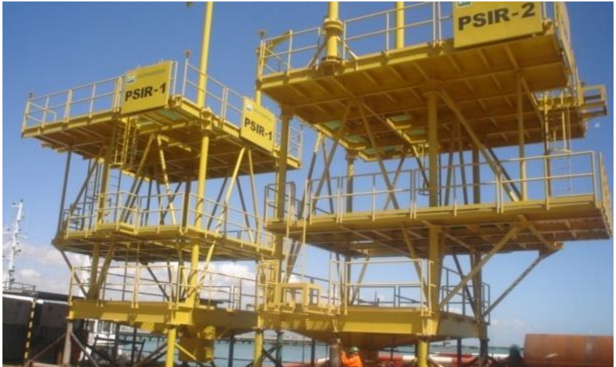
Estruturas das plataformas Caisson PSIR-1 e PSIR-2
