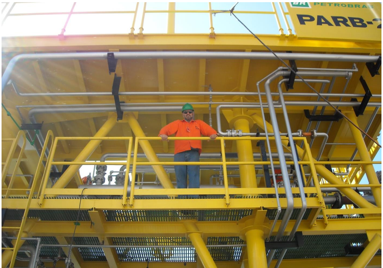
Plataforma Caisson PARB-2
