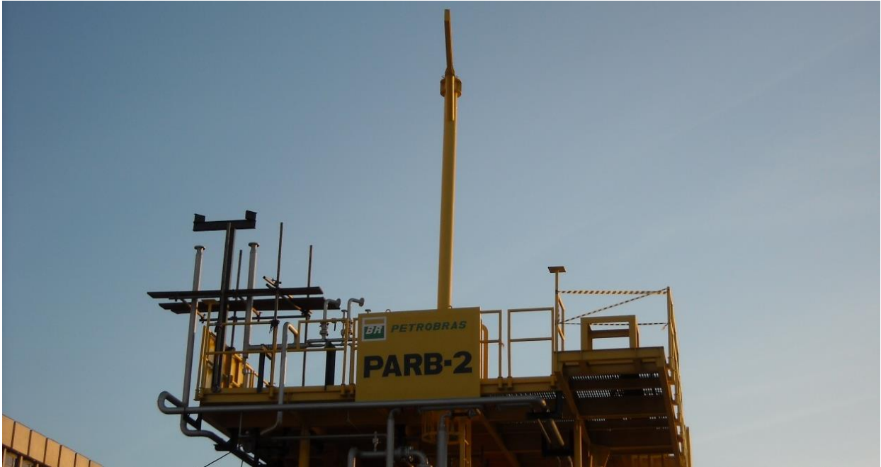
Plataforma Caisson PARB-2
