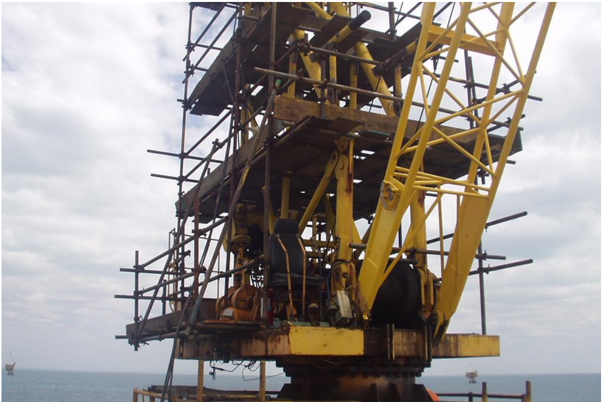
Planejamento e controle da repintura de plataformas da bacia potiguar. Na imagem, o guindaste HR GB-35M da PUB-4 sendo repintado.
