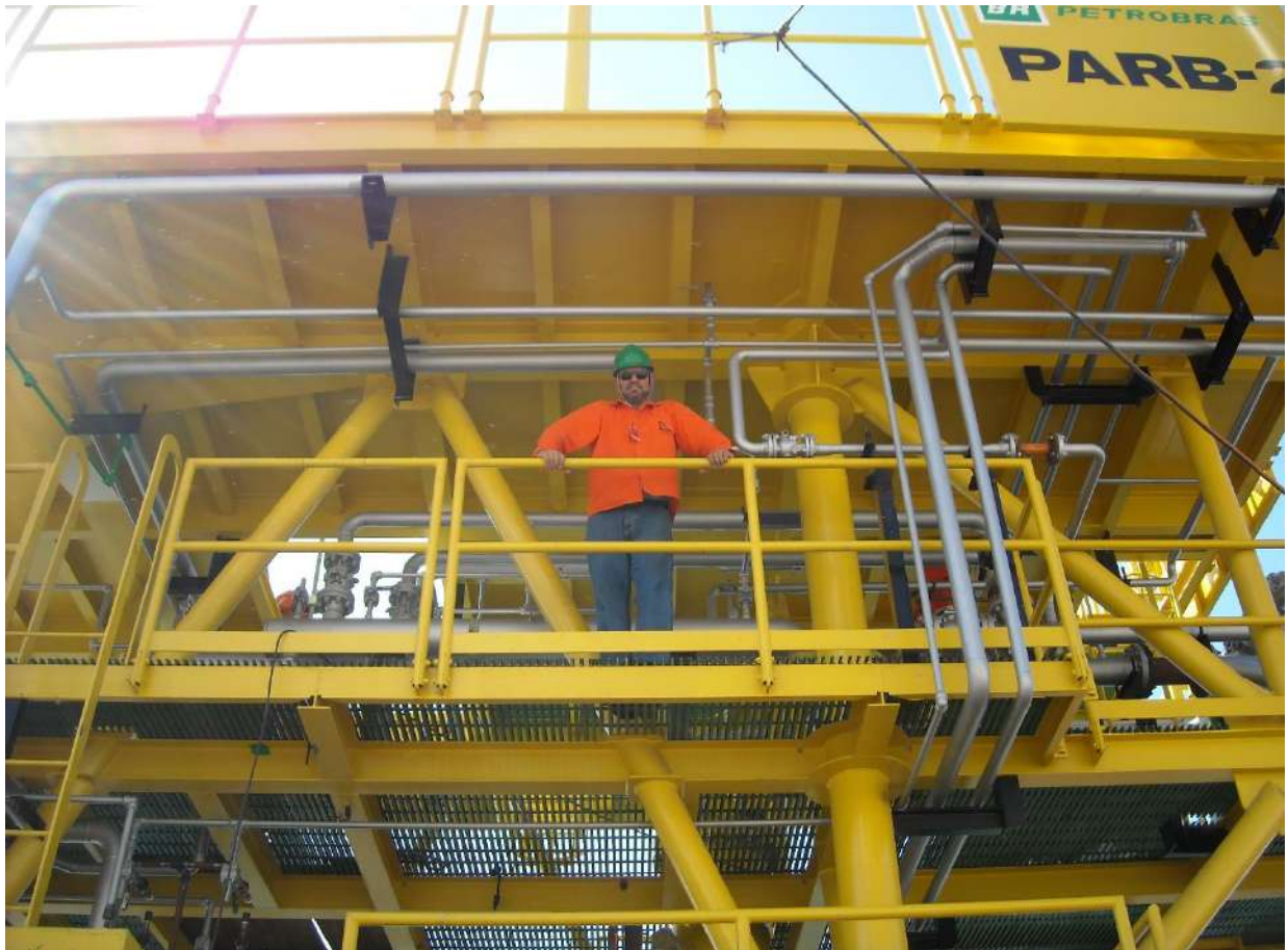
Plataforma PARB-2, construída pela ASRISAM.
