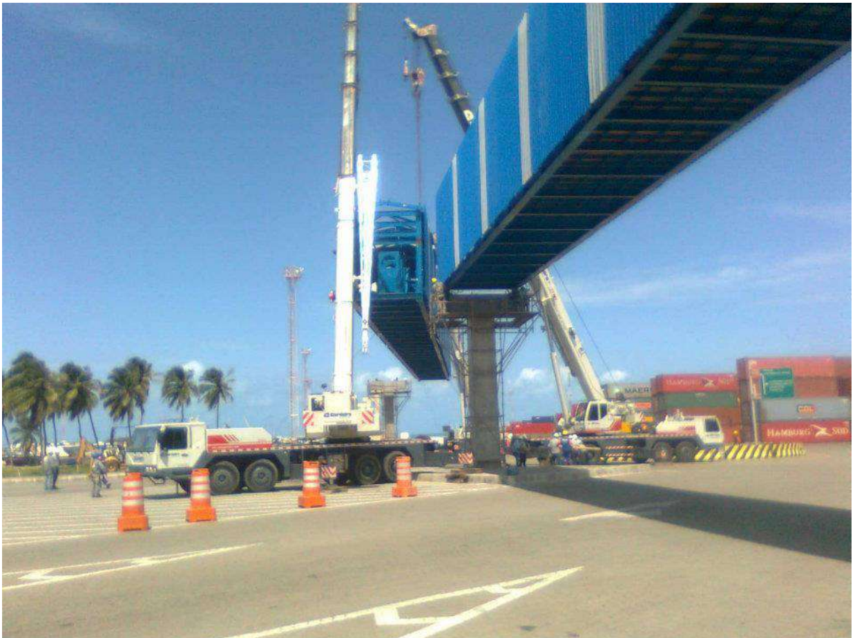
Montagem de módulos da correia transportadora de carvão mineral em Pecém, pela KOCH Tecnometal
