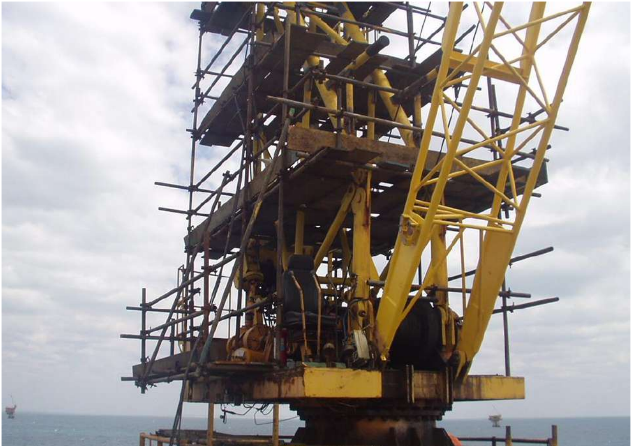
Repintura do guindaste HR GB-35M da PUB-4, pela ENGEQUIP
