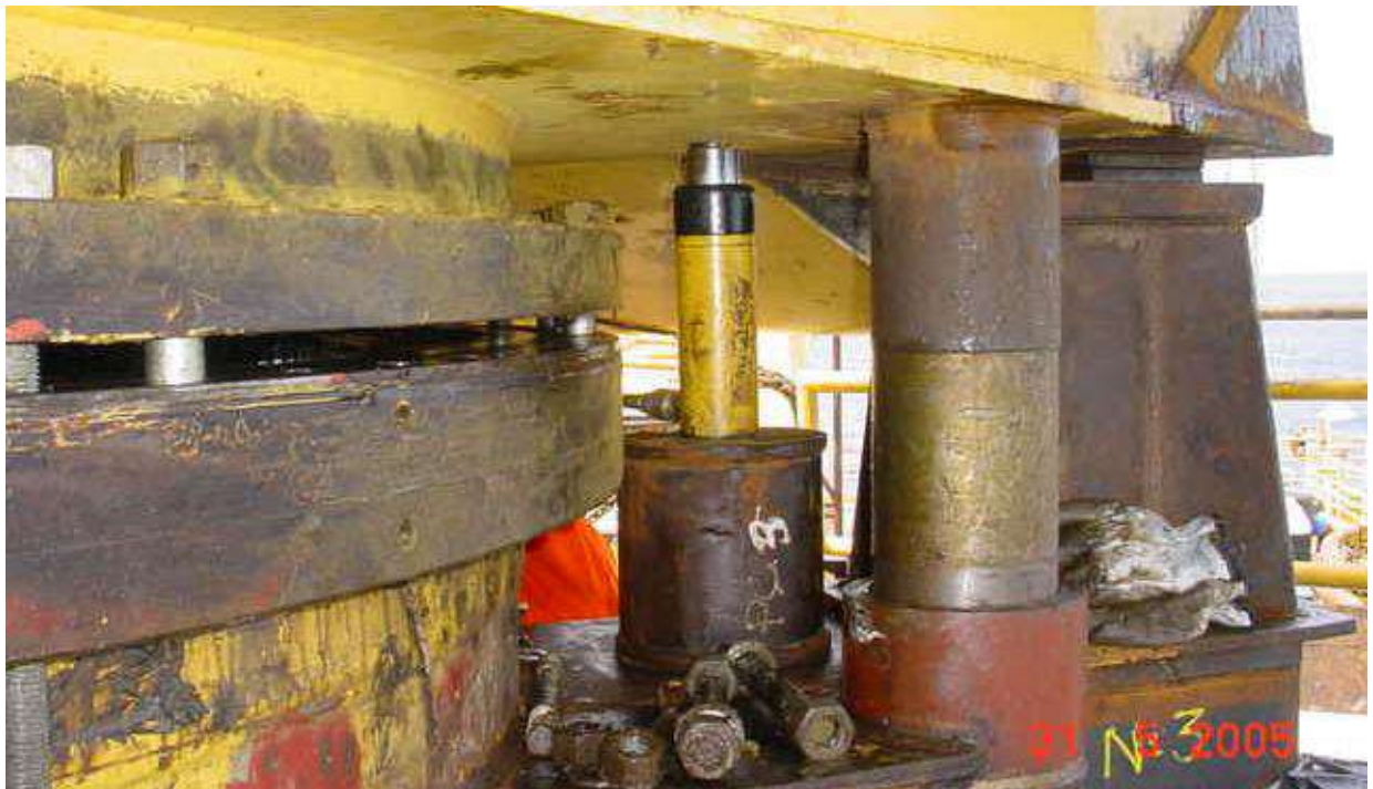
Detalhe do projeto do sistema estrutural para substituição da pista de giro do guindaste
